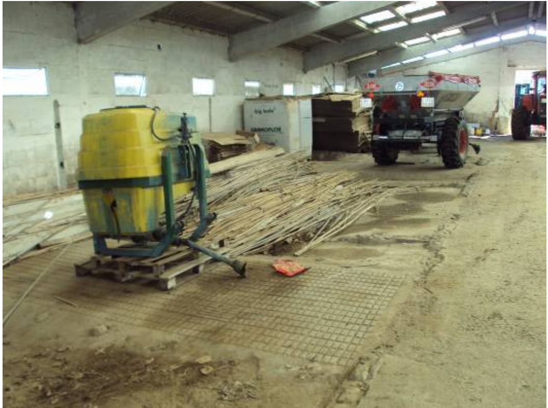
Nave lista para su rehabilitación como aprisco, para el nuevo rebaño de 200 reproductoras en el núcleo de la Mota
